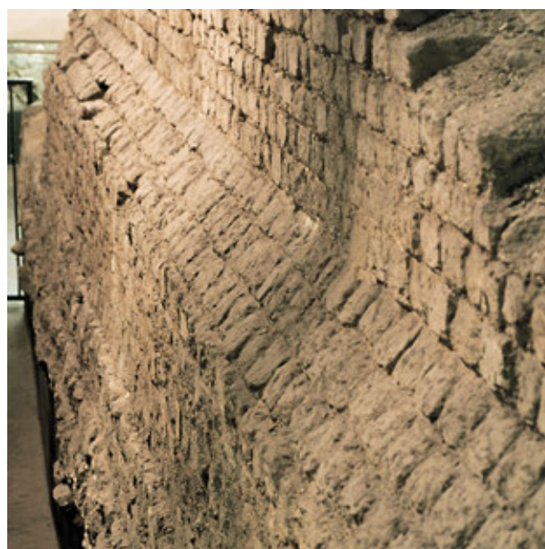
Abb. 141 Außenansicht der römischen Stadtmauer mit den sorgfältig bearbeiteten Hausteinen in der Tiefgarage unter dem Dom; der Sockel, auf dem sich das aufgehende Mauerwerk erhob, ist deutlich zu erkennen.
